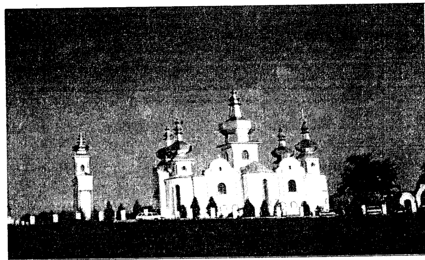
Церква Успіння Пресвятої Богородиці в с. Сокильники коло Львова Архітектор: Іван Трубий з с. Мишана на Лемківщині. (до 10-річчя початку будівництва).
