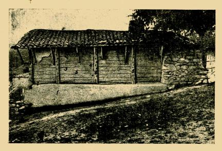
Рис. 9. Стена с деталями постройки; скрепления плах: 1) каменный фундамент, 2) продольные бревна, 3) стены, 4) сруб, 5) колышек, гвоздь, 6) упоры, 7) черепица, 8) упоры (Дом Бекир Умерова, дер. Юкары-Каралез.)
