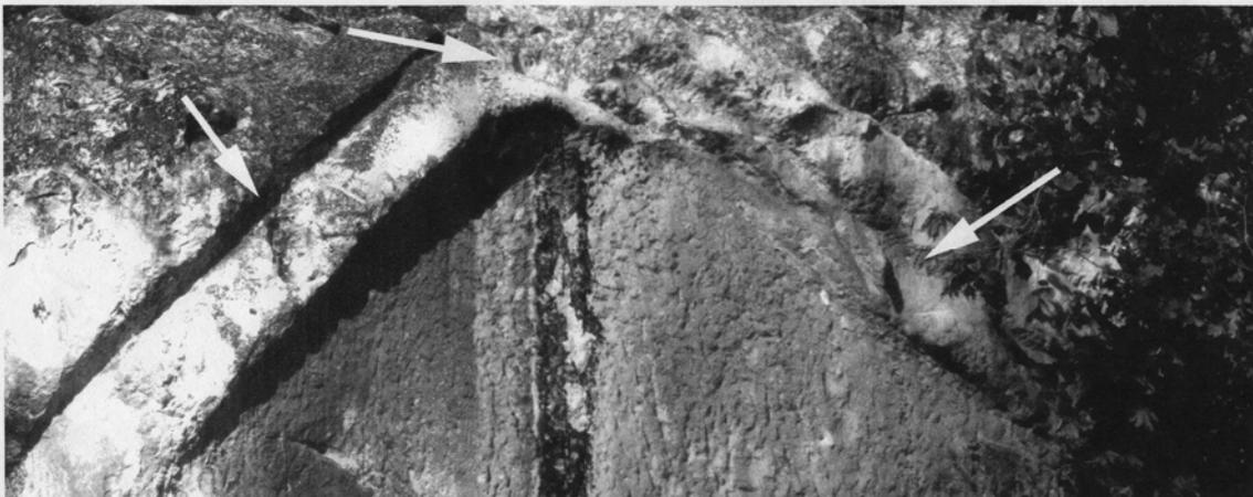
Рис. 16. Пазы для установки продольных кровельных балок притвора
