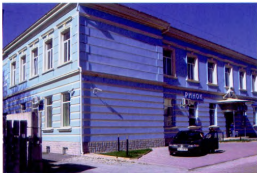
Механічно-Слюсарська Школа (1909) на Зарудді. Фото 2007 р.
