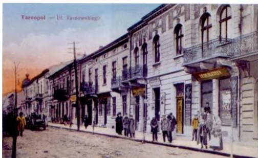
Вул. Тарновського. Південна сторона. Листівка
