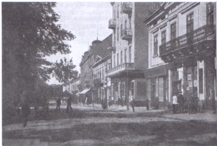
Вул. Міцкевича. Східна сторона. Вид із півдня.
