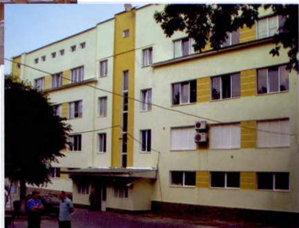
Фабрика "Червона Калина" на вул. Пунтшерта. ▶ Фото 2007 р.
