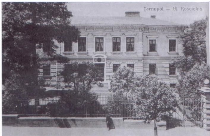
Будинок на вул. Костьольній. Листівка
