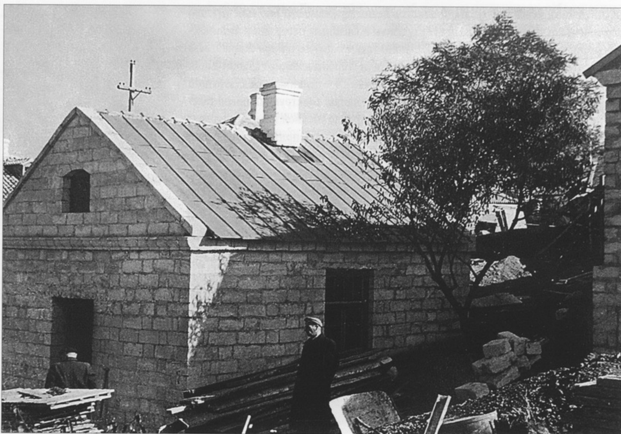
Рис. 2. Строительство входного навильона и дома для смотрителя в 1959 г. (Архив КИКЗ)
