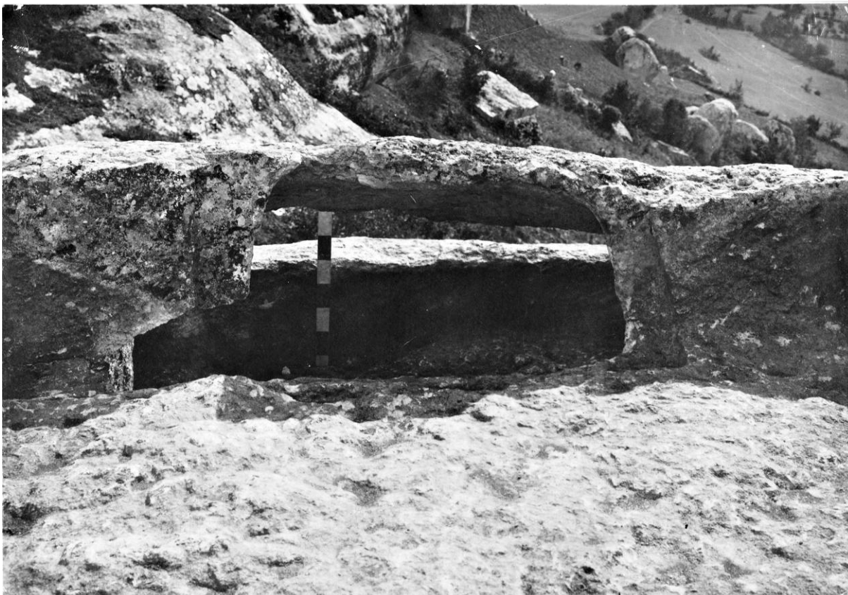
Рис. 9. «Остатки часовни на месте башни X. Вид с юга на алтарную часть и с севера на усыпальницу» [1, л. 60]
