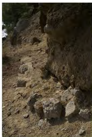
Фото 23. Помещение со следами штукатурки. Остатки северо-восточной стены.
