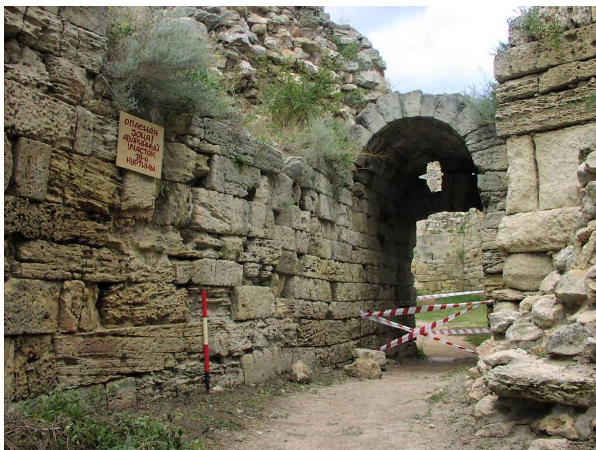
Рис. 4. Арочный свод калитки 19 куртины. Вид со стороны цитадели
