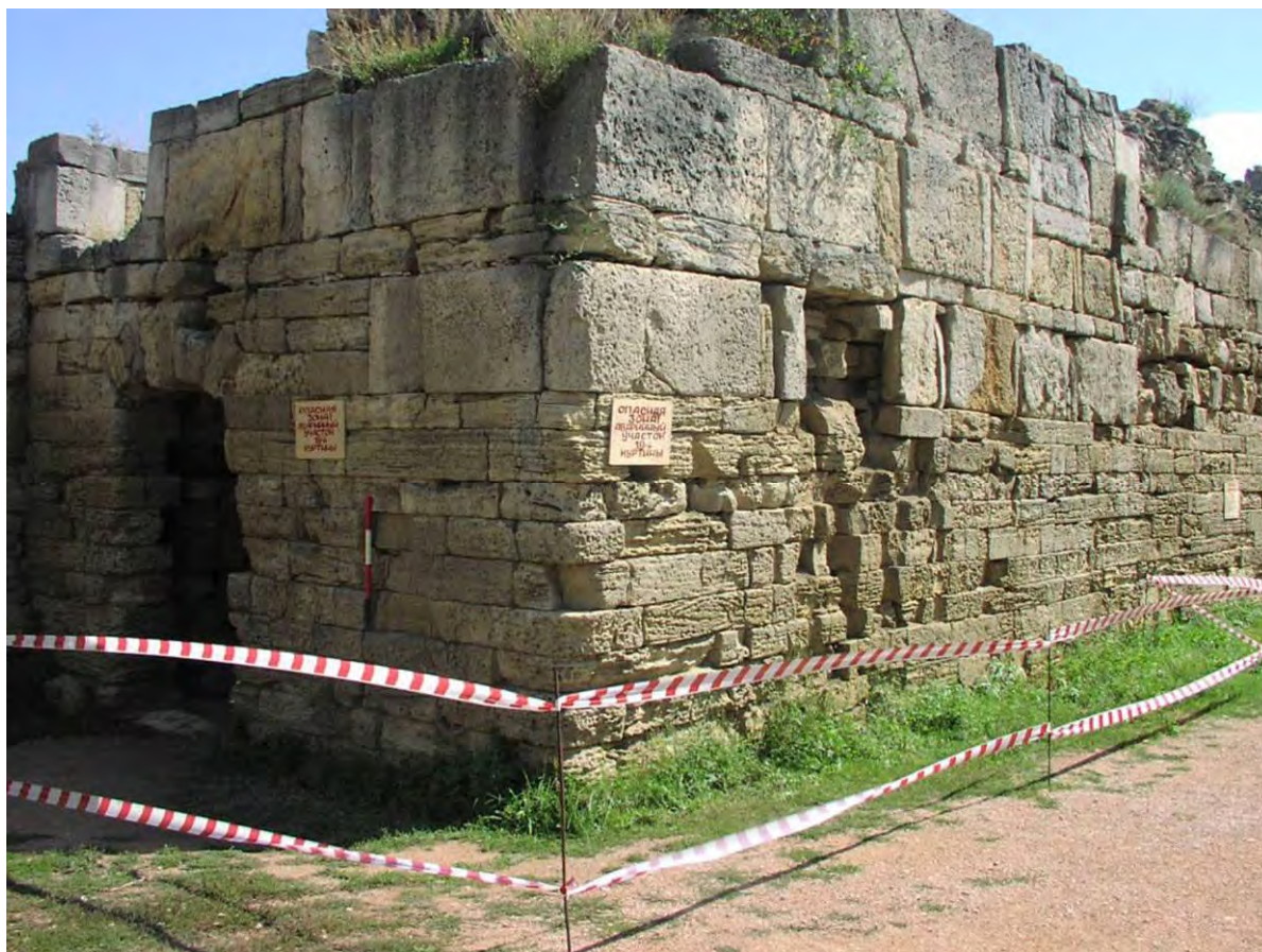
Рис. 3. Северо-западный угол куртины перед началом работ
