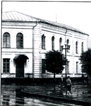
Західний фасад будинку колишньої Жіночої маріїнської гімназії
