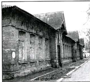
Лікувальний корпус, збудований у 1904 р. в у стилі псевдомодерну
