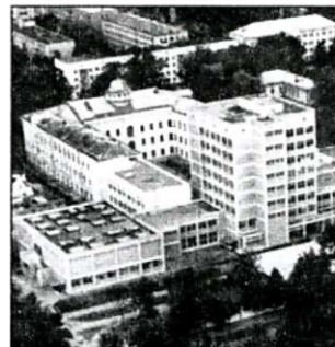
Вигляд на комплекс будівель університету ім. Івана Франка з гелікоптера (з півдня). 1992 р.
