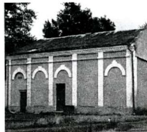
Будівля колишнього дизельного відділення міської електростанції (тепер тягова станція контактної трамвайно-тролейбусної мережі).
