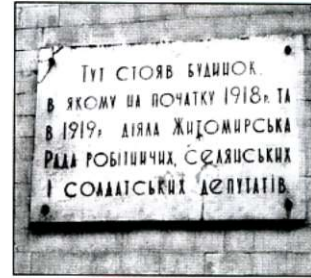
Пам'ятна дошка на східному ризаліті будинку колишнього Дворянського зібрання. На дошці помилково сказано, що «тут стояв будинок», оскільки усі його несучі стіни і конструкції, кількість і розміщення віконних прорізів зберіглись.
