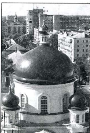
Йде реконструкція будівлі Свято-Михайлівського собору — пам'ятки історії та архітектури
