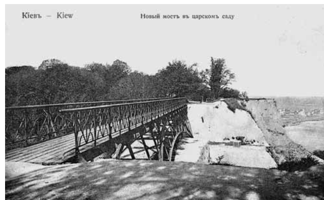
Пешеходный мост в Царском саду над Петровской аллеей, инж. Е. О. Патон, 1912 г., фото из архива В. Е. Ясевича
