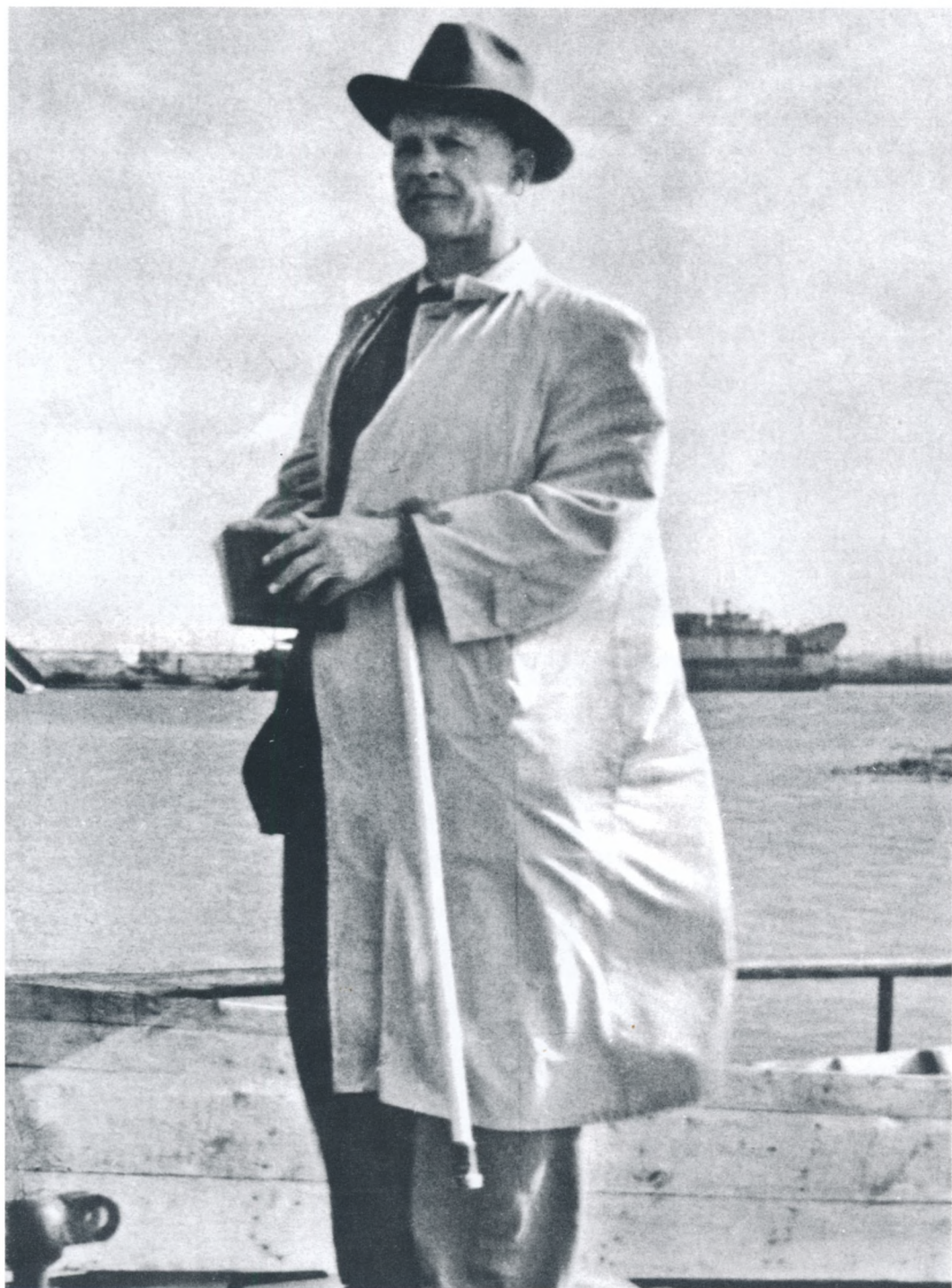
А. П. Довженко на строительстве Каховской ГЭС. Город Новая Каховка Херсонской области. 1952 г. ЦГКФА Украины им. Г. С. Пшеничного, ед. уч. 0-82095
