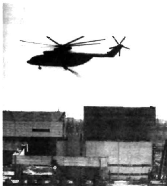
Так засипали пролом у даху 4-го блока ЧАЕС. Квітень 1986 року
