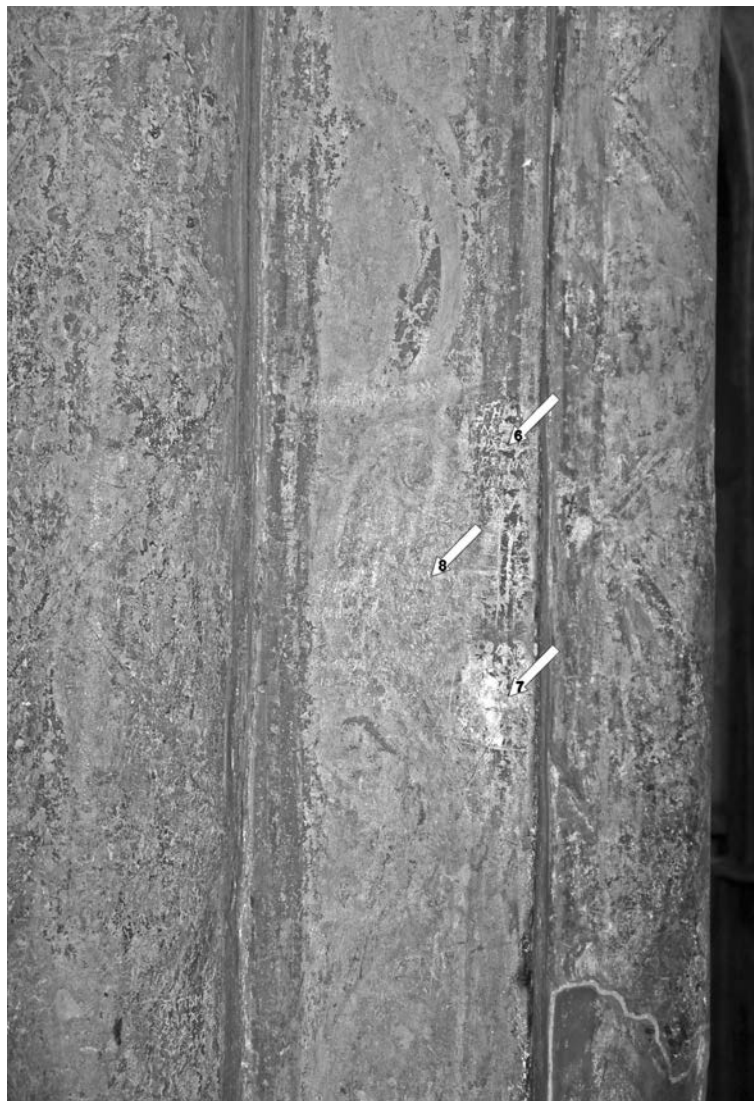
Рис. XVII. Северо-западный пучковый столб на северных хорах (II, 13).
