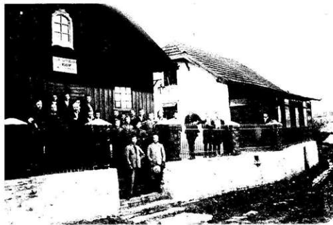
Злива будинок для збірання і театральних вистав збудованій 1926 р. коштом Кооперативу «Косарі» з травяни — читальни «Прогнітня».
