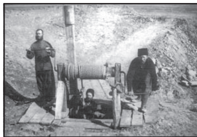
Проходка шурфу на землях поміщика Білокрисенка біля с. Веселі Терни, 1913 р.
