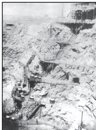
Похилий підйомник, що обслуговував кілька горизонтів на Веселоіванівському руднику («Жовта Річка»), 1911 р.
