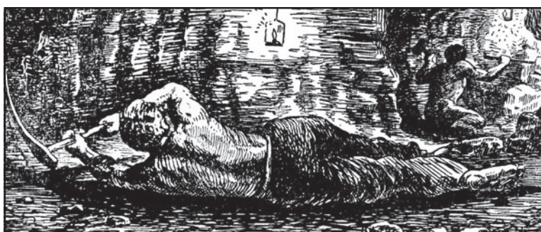
Вирубання за допомогою кайла врубу у підшві вугільного пласта
