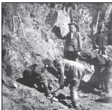
Зарядка шпурів для підривання скельних гірських порід, рудник «Шмаковський», 1903 р.
