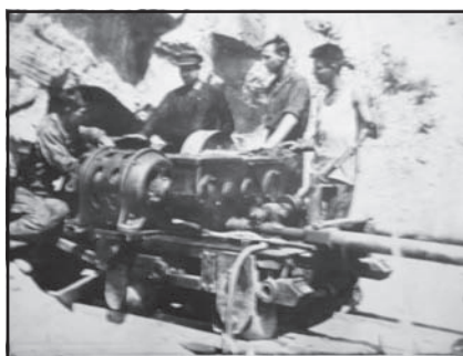
Україна. Перший в світі вугледобувний комбайн конструкції О.І. Бахмутського
