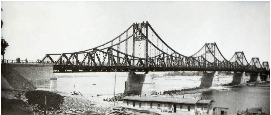
Загальний вигляд мосту ім. Є.Б. Бош через Дніпро. Київ, 1925 р.
