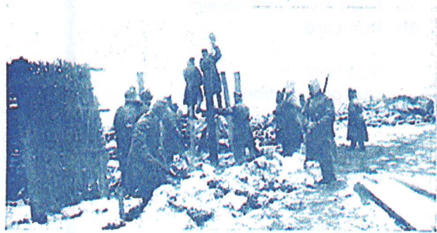
Ukrainische Legion an der Strypa. Einrammen von Pfählen. „Sumpfschanze.“
